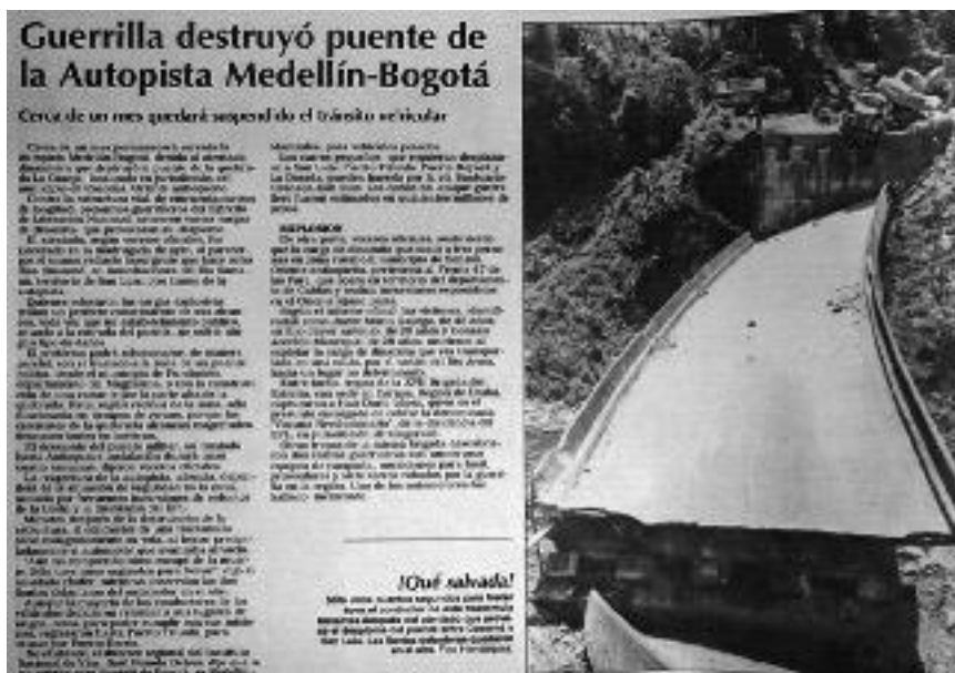
“Guerrilla destruyó puente de la autopista Medellín-Bogotá”. Fuente: El Colombiano (1994, 6 de agosto), página 8B.
